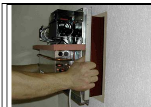
Collocare il climatizzatore nel telaio (vista lato cantina dei vini)
