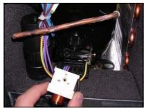
Câbler le nouvel ensemble (condensateur entre bornes 11 et 13)
